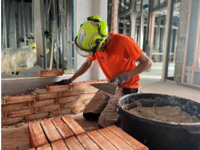
Innvendige teglvegger er på veg opp.
